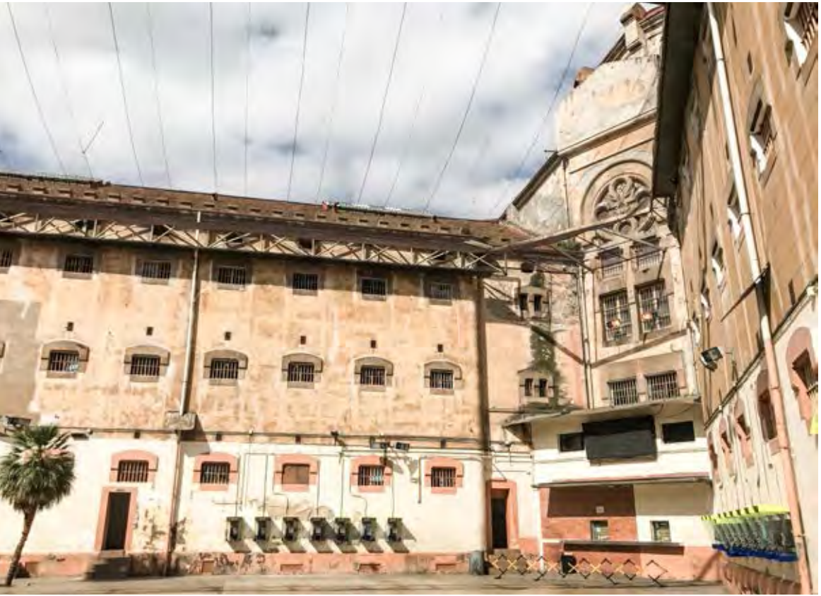
Les cabines, la comunicació amb l'exterior
