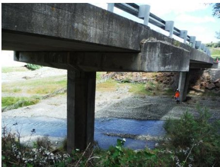
(d) Wandle River Bridge – Inland Road
