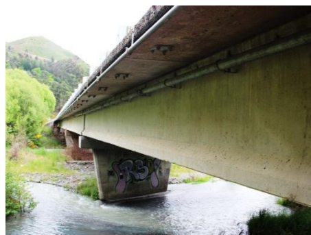
(d) Hanmer River Bridge SH7A
