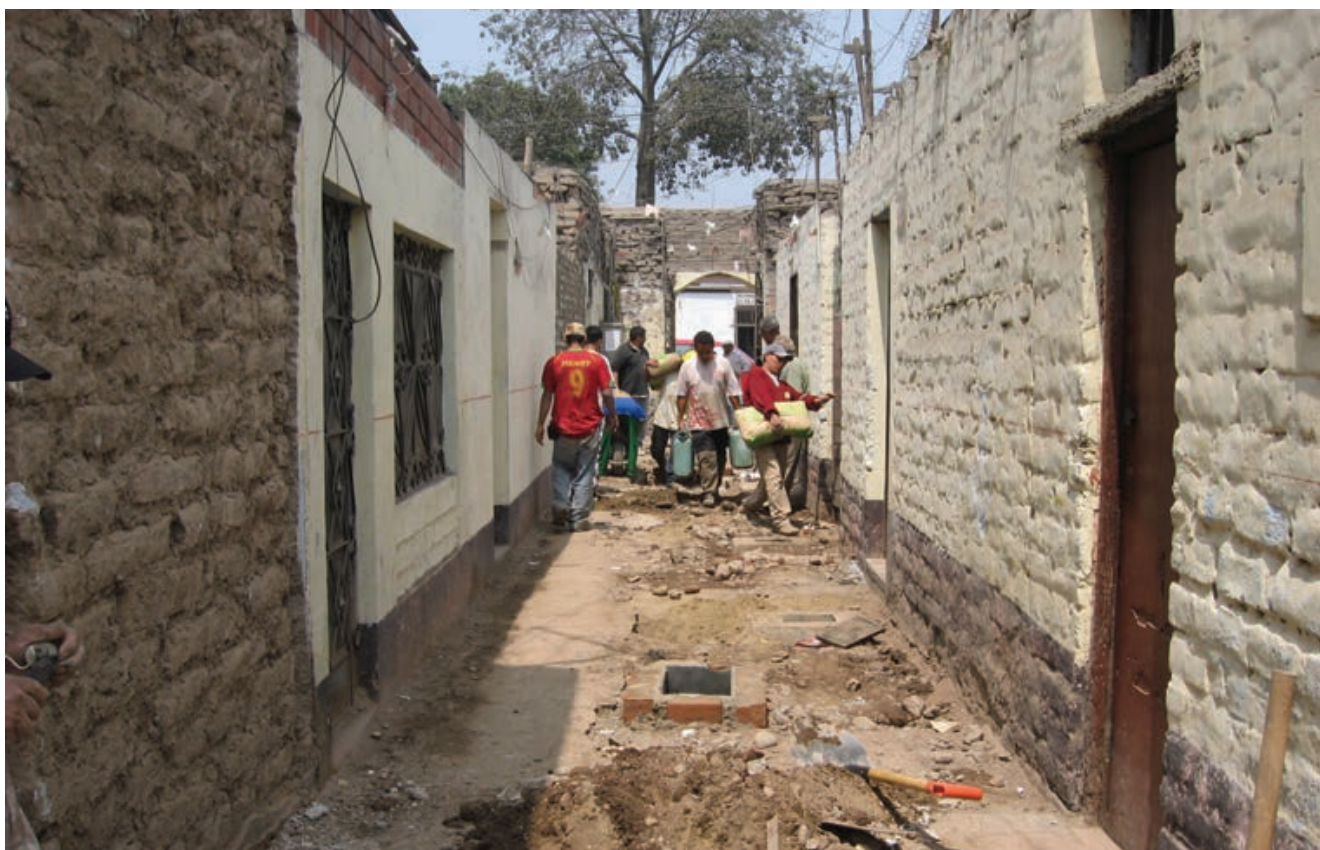
Foto 4 Inversiones colectivas dentro de una quinta en Barrios Altos para extender las conexiones de agua y alcantarillado a cada vivienda.
