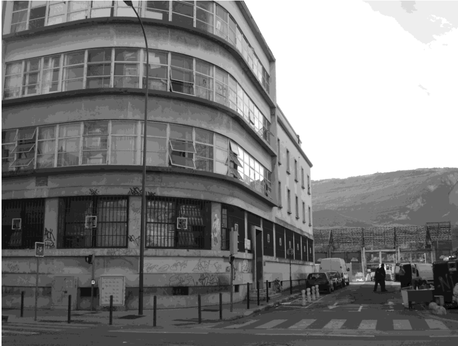
Illustration 2 : L'immeuble de la SDEM abritant le Brise Glace (L.A 2006)
