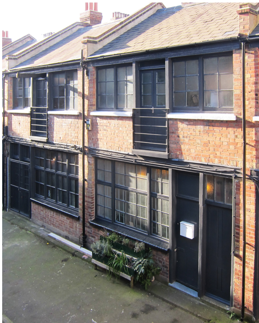
Fig. 5 - Workshops in middle of block, Winkley Estate. Laboratori interni all'isolato, Winkley Estate.
