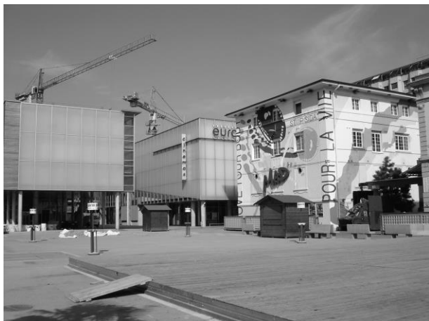
Figure 7 : le nouveau Flon, entre nouveaux et anciens bâtiments (L.A, 2006)
