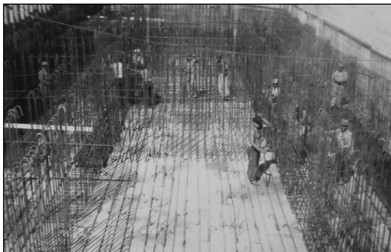
Figura 6-7 Operai negli scavi di fondazione dell'edificio della centrale. Fonte: ASE Giancarlo Vallauri Torino, Società Elettronucleare Nazionale Senn, Visita Sopralluogo compiuta sull'impianto della Società Elettro-Nucleare (SENN) – Finanziato dalla BIRS – Il giorno 22 settembre 1960.
