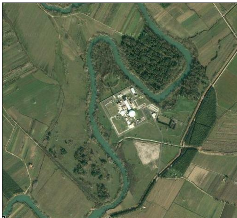
Figura 6-4 Immagine della Centrale scattata dal satellite. Confrontando le due immagini è possibile riconoscere l'area di rispetto della centrale, in cui ai piccoli appezzamenti presumibilmente coltivati si è sostituito un terreno boscoso a nord della centrale e prevalentemente lasciato a prato a sud. Fonte: Google map, 22/07/2010, http://maps.google.it/maps?q=sessa+aurunca+map&um=1&ie=UTF-8&hq=&hnear=Sessa+Aurunca+CE&gl=it&ei=yBZITO6fJZuI4gayj7ihDA&sa=X&oi=geocode_result&ct=image&resnum=1&ved=0CBcQ8gEw .
