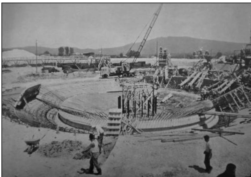
Figura 5-2 I lavori della fondazione della sfera del reattore. Fonte: ASE, Fondo nazionalizzazione imprese elettriche - Direzione Generale, Bilanci e relazioni a stampa, Bilancio 1959.
