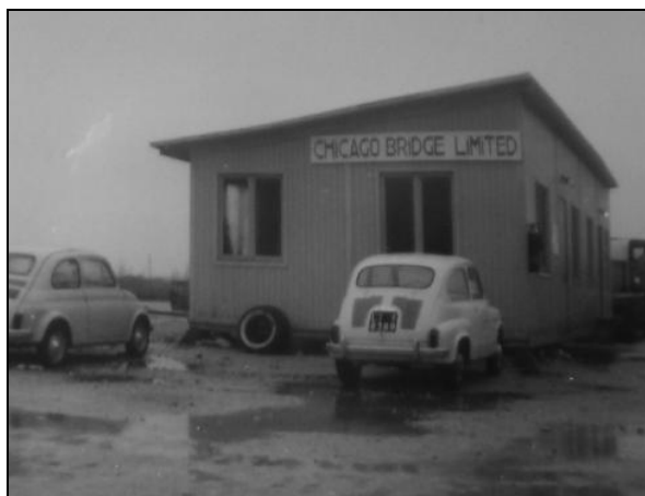
Figura 6-8 Foto dell'edificio riservato ai tecnici della compagnia Chicago Bridge Limited. Tratta da "Sopraluogo compiuto sull'impianto della Società Elettronucleare Nazionale (SENN) – Finanziato dalla "BIRS" il giorno 15 dicembre 1960. Fonte: ASE Giancarlo Vallauri Torino, Società Elettronucleare Senn.
