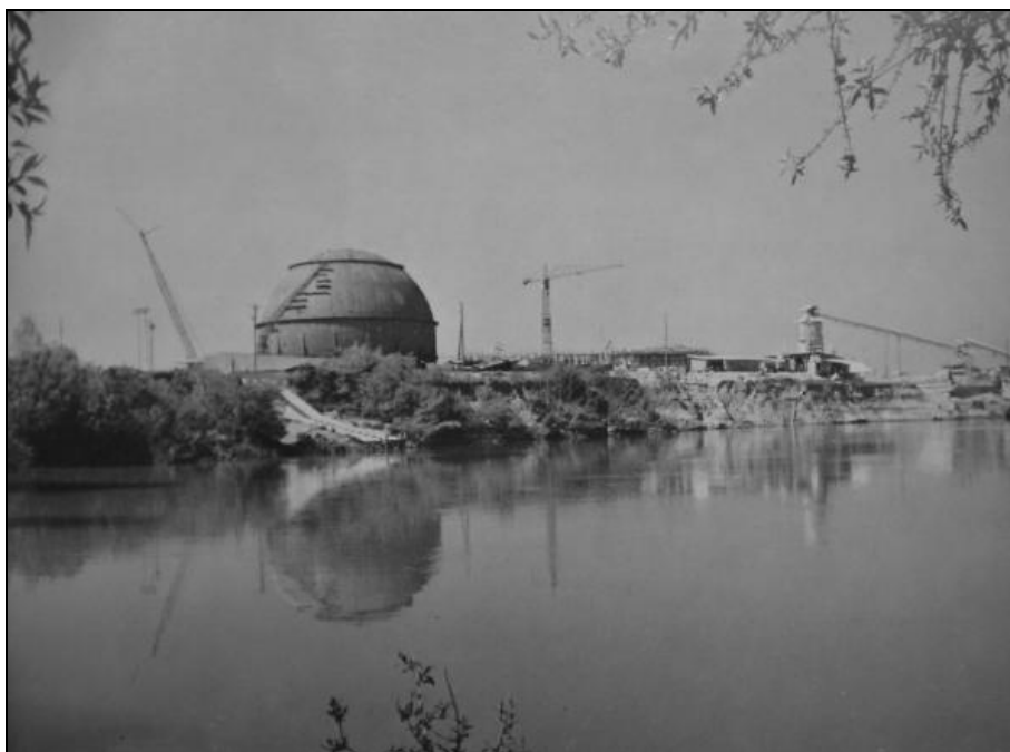
Figura 5-3 I lavori di costruzione della centrale. Fonte: ASE, Fondo nazionalizzazione imprese elettriche - Direzione Generale, Bilanci e relazioni a stampa, Bilancio 1960.
